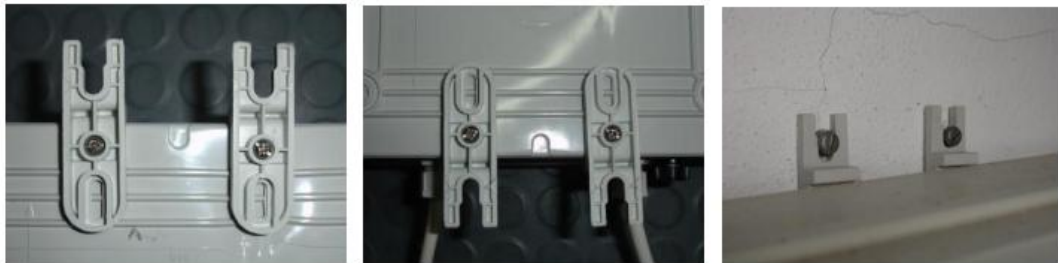
Fijaciones del Panel Eléctrico de Hidrion a la pared.
